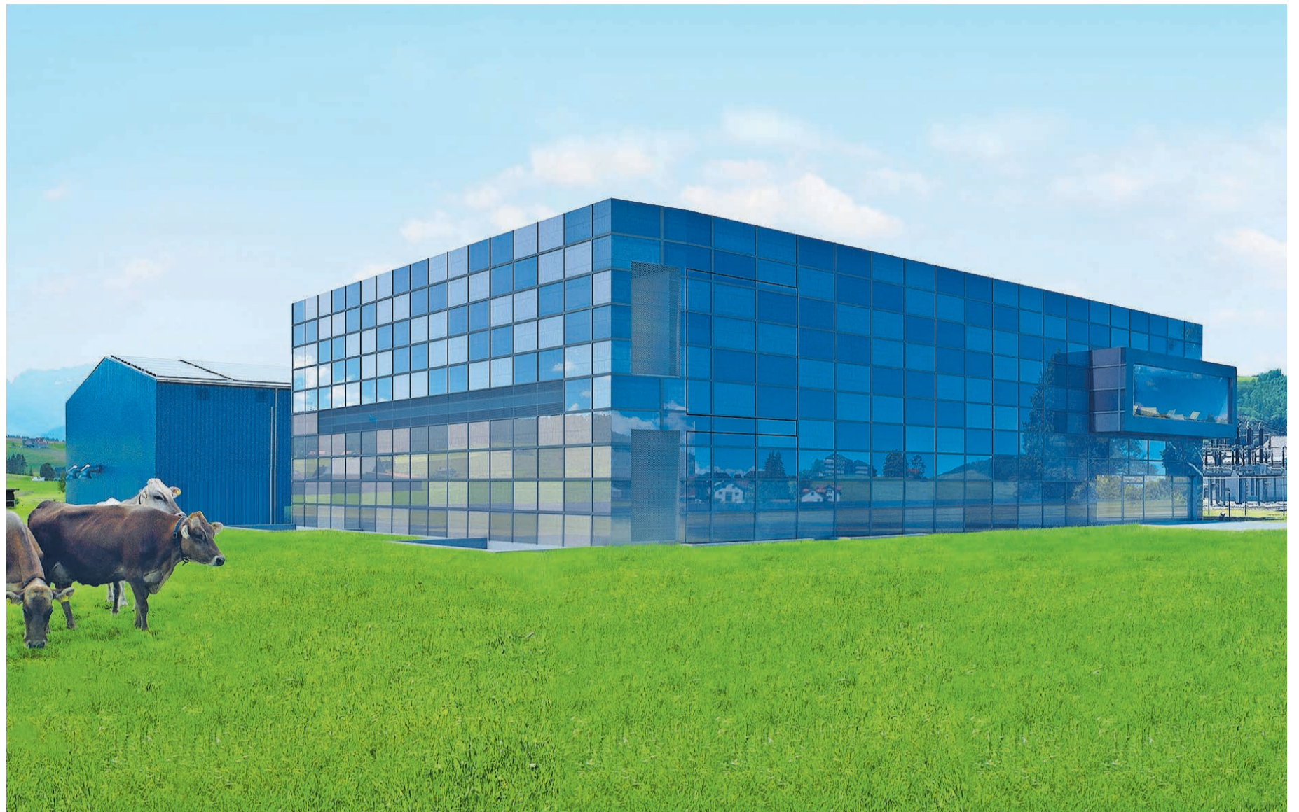
Das geplante Rechenzentrum Ostschweiz in der Gewerbezone Gais, rechts das bestehende SAK-Unterwerk, links das Käselager der Berg-Käserei.
